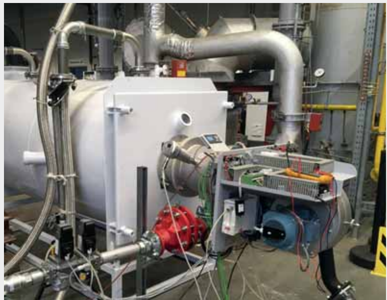
Bild 4: Versuchsbrenner und Prüfflammrohr
